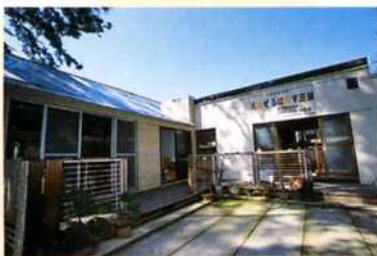
松林近くの新・保護施設。寄付された廃材を利用して建てられています
